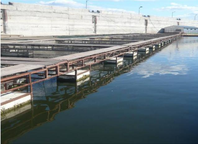
Рис. 4. Общий вид садковой линии на пенопластовых понтонах для выращивания товарных осетровых рыб
