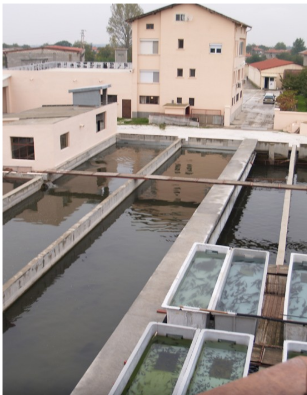
Рис.4. Участок бетонных бассейнов
